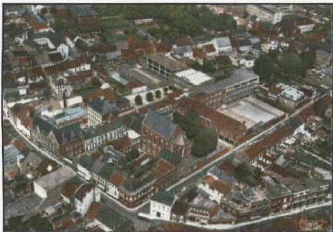
Le Collège : Vue aérienne
